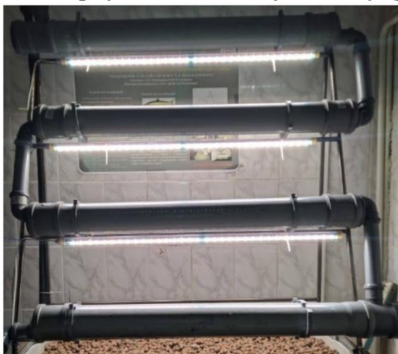
Рисунок 2. Светодиодная (биколорная) лампа для гидропонного модуля
